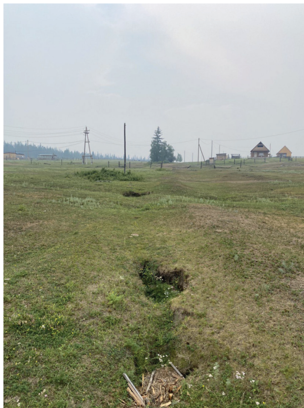
Рис. 4. Колодцы, образованные просадкой грунта
